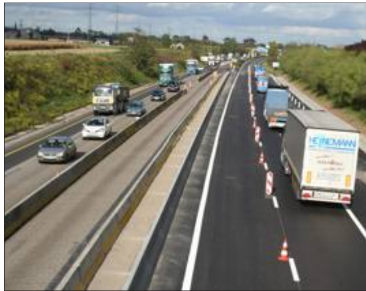
La circulation devrait être totalement rétablie dans la nuit du 8 au 9 novembre ou celle du 12 au 13 novembre. Photo Françoise Marissal
